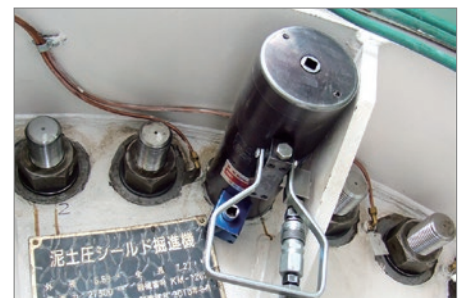
シールドマシンの組立、壁際の狭隙部ボルト締め
