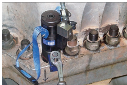
ガスタービンのケーシングボルト締め
