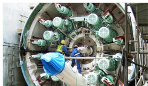
シールドマシンの組立て・据え付け
