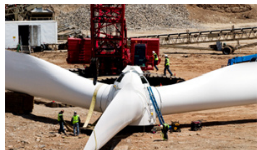
風力発電の組立て・メンテナンス
