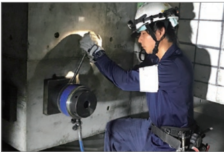
PC鋼棒の緊張作業へ実績多数。緊張ジャッキの1/4の軽さ
