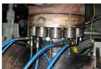
フランジボルトを全数同時に締結
