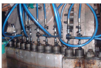
火力発電ガスタービンのボルト締め
